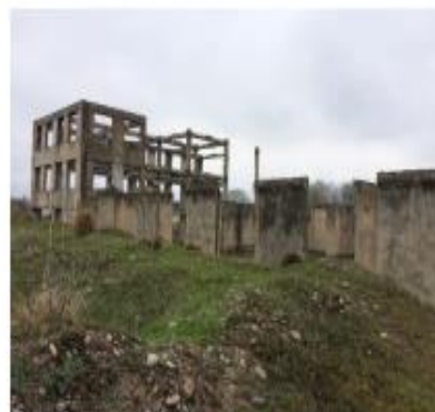
Здание песчаных фильтров
