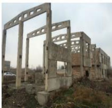
Здание реагентного хозяйства
