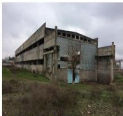
Насосная станция (снаружи)
